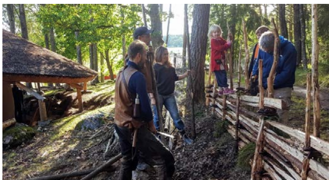
Bygge av gårdsgård i Hölö, Sörmland.
